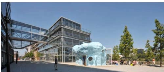
L'Absence, Atelier Van Lieshout, Ecole d'architecture, Lacaton et Vassal, Ile de Nantes
