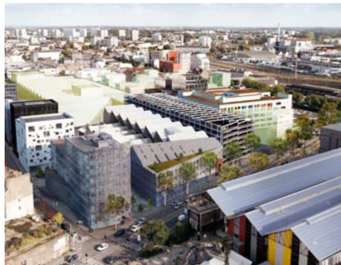
Quartier de la Création, Ile de Nantes
